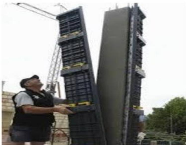
Рисунок Б.9 – Распалубливание колонны
