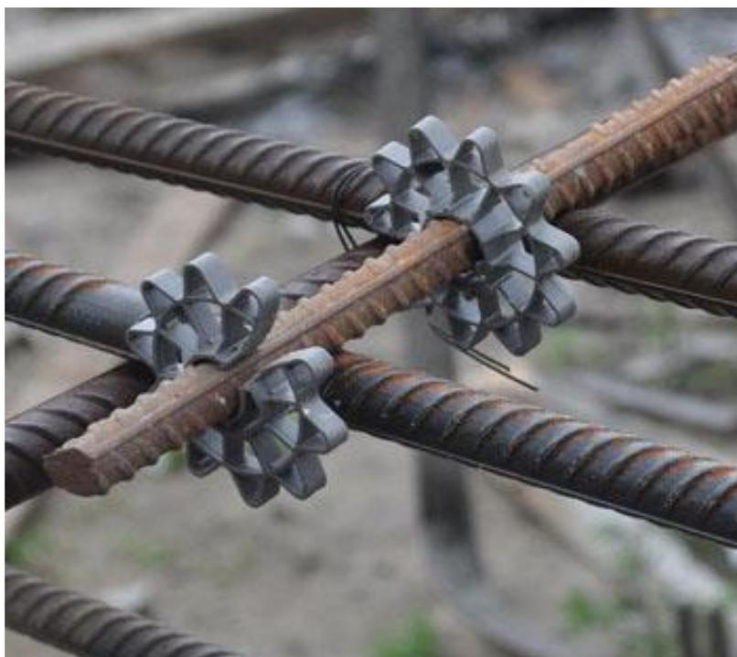
Рисунок Б.6 – Фиксаторы защитного слоя
