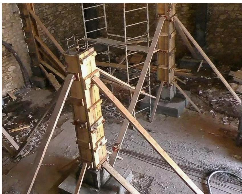
Рисунок Б.7 – Устройство опалубки колонны
