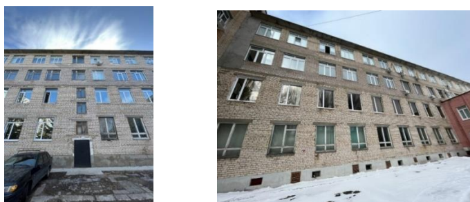
Рисунок 2 – Северный и южный фасады четырехэтажного блока корпуса «Д»
