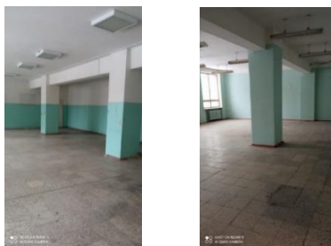
Рисунок 3 – Колонны и ригели (1-й этаж)
