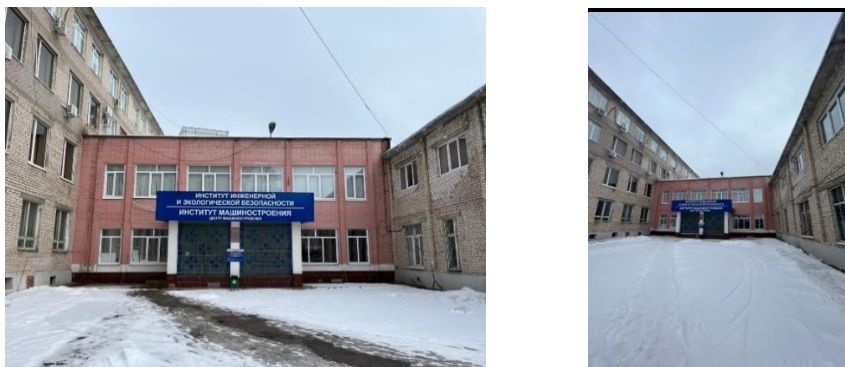
Рисунок 1 – Вход в корпуса «Б» и «Д» с западной стороны
