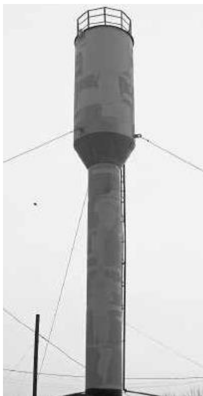
Рисунок 6 – Водонапорная башня поселка Мургаб
