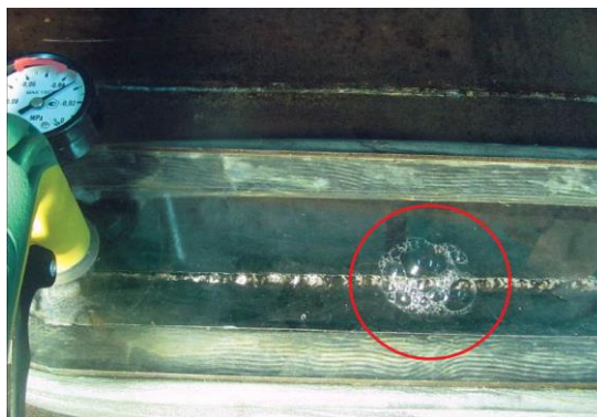
Рисунок 14 – Проверка герметичности сварных швов
