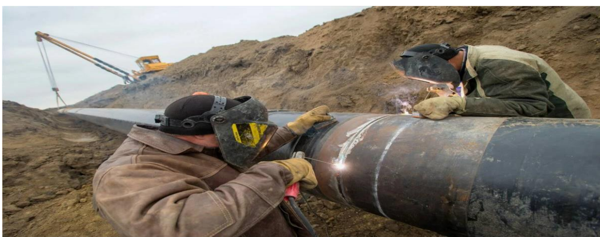
Рисунок 20 - Сварка нефтепровода БТС-2
