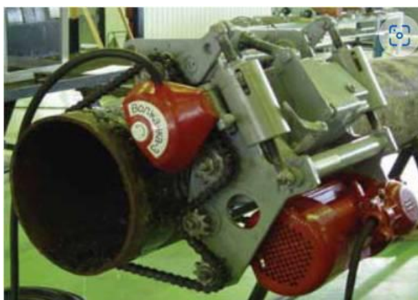
Рисунок 10- Резка поврежденного участка нефтепровода
