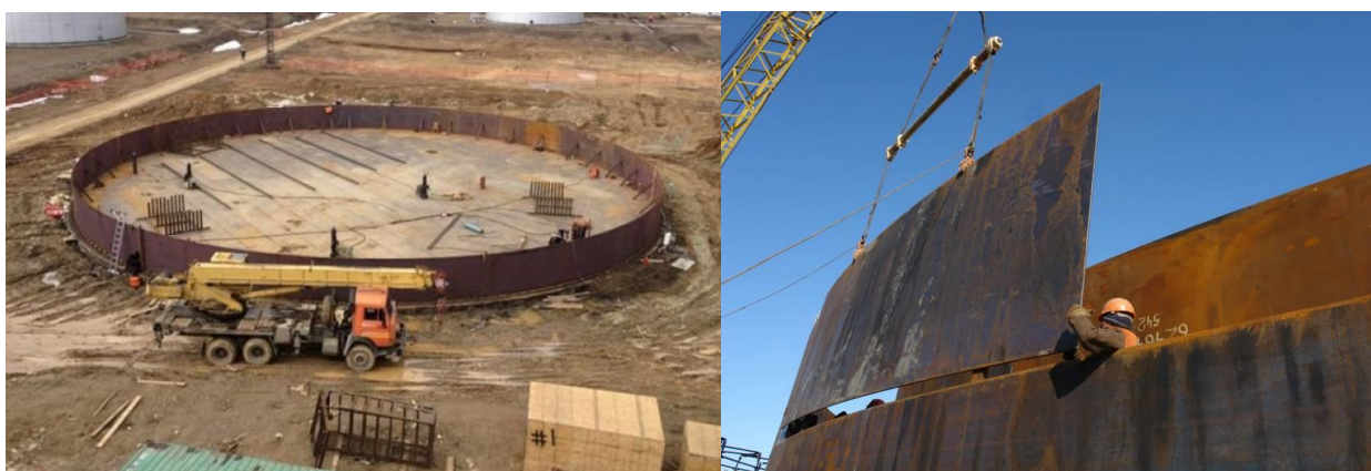
Рисунок 3 – Метод наращивания поясов при возведении резервуара
