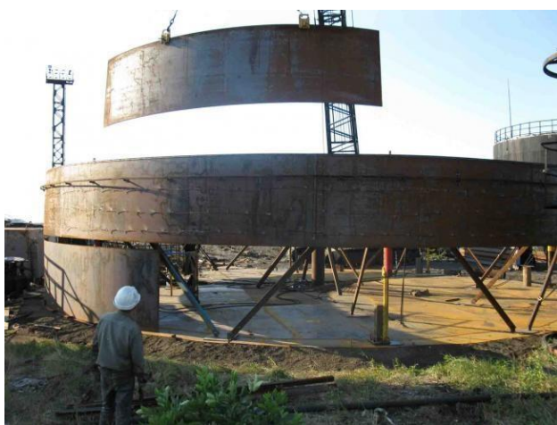
Рисунок 4 – Возведение резервуара методом подращивания
