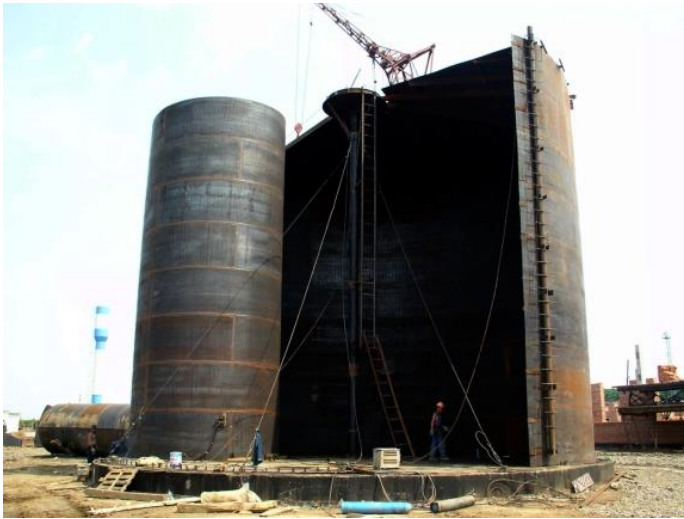
Рисунок 5 – Возведение резервуара методом рулонирования
