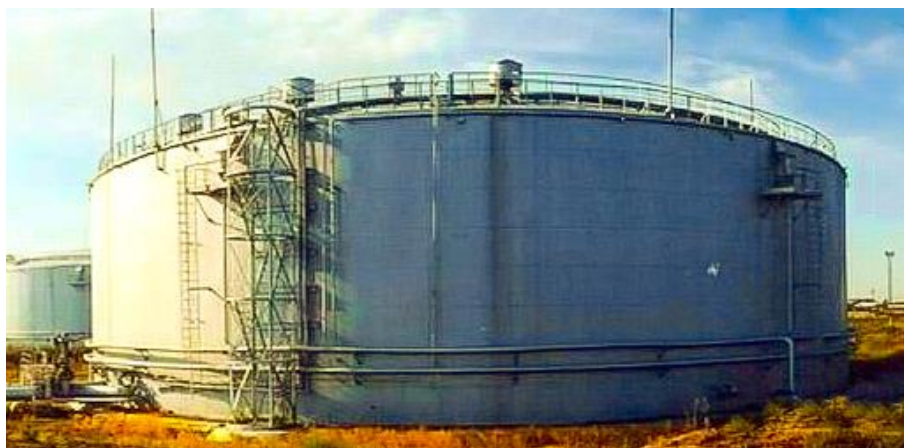
Рисунок 1 – Резервуар для авиационного топлива РВСП-20000
