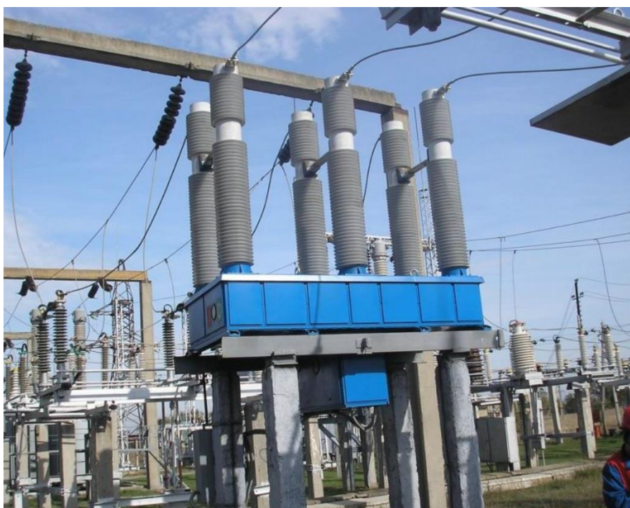
Рисунок 3 – Выключатель 110 кВ
