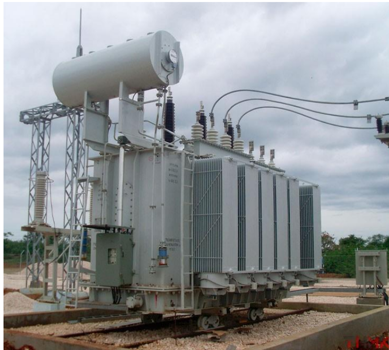
Рисунок 1 – Трансформатор ТРДН-25000/110
