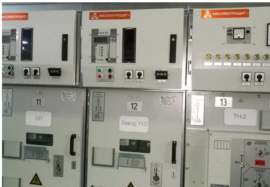
Рисунок 6 – Ячейки КРУ
