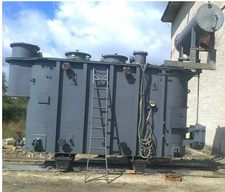
Рисунок 3 – Трансформатор ТМН-6300/110
