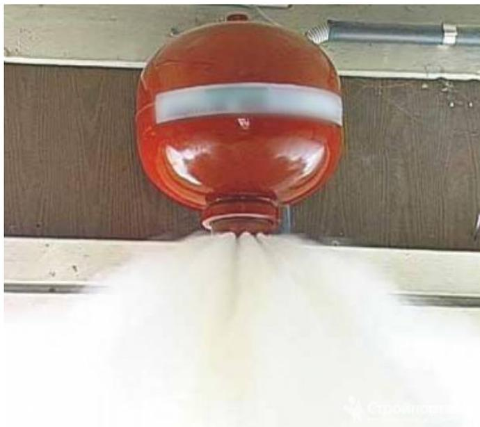
Рисунок 3 – Система порошкового тушения
