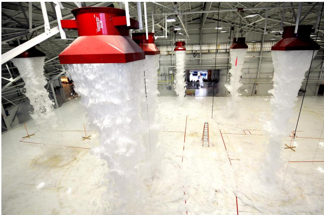
Рисунок 2 – Система пенного тушения
