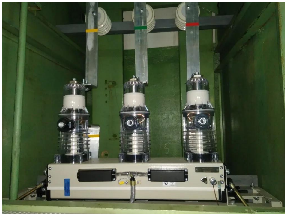
Рисунок 7 – Выключатель ВВ/TEL-10
