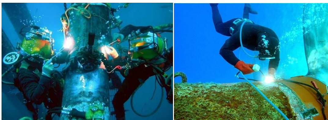
Рисунок 1 – Подводная ремонтная сварка трубопровода
