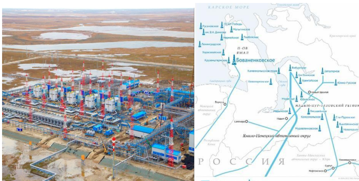
Рисунок 6 – Газовый промысел № 3 Бованенковского месторождения
