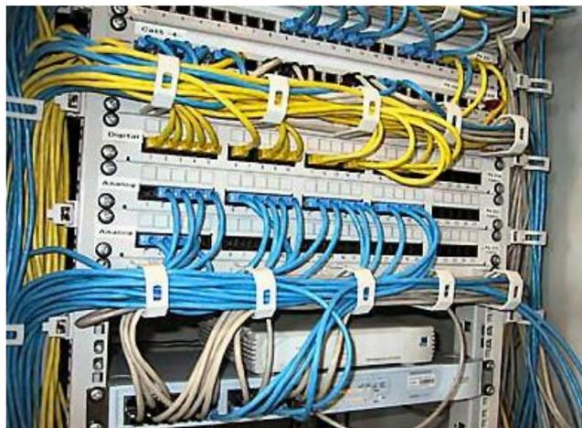
Рисунок 14 – Панель коммутации
