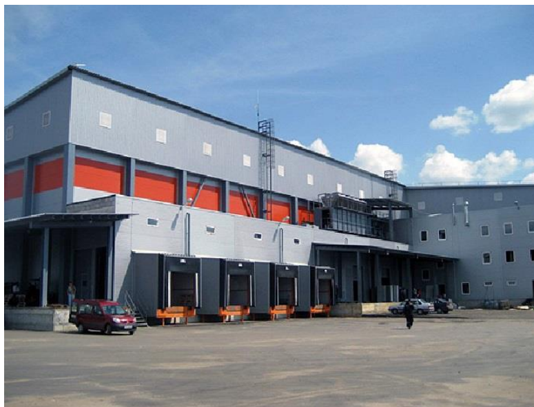
Рисунок 4 – Внешний вид торца здания ООО «СВ-Нефть»
