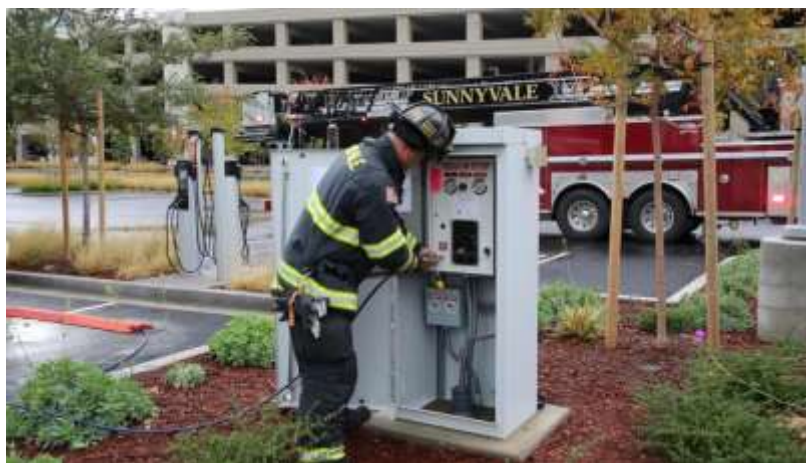
Рисунок 5 – Пожарный, подключающий MAU к EMAC, установленному в удаленном запираемом шкафу
