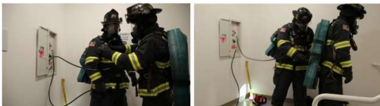
Рисунок 6 – Пожарные заправляют баллоны с воздухом через соединение с внутренней панелью наполнения воздухом
