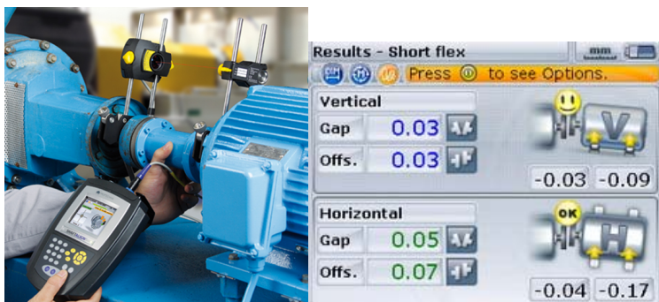
Рис. 8.7. Лазерная установка для контроля соосности валов при монтаже оборудования
