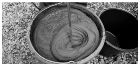
Рисунок 3.3 – Приготовление клеевого состава
