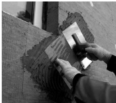
Рисунок 3.11 – Установка усиливающих элементов
