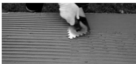
Рисунок 3.4 – Нанесение клея сплошным методом приклейки
