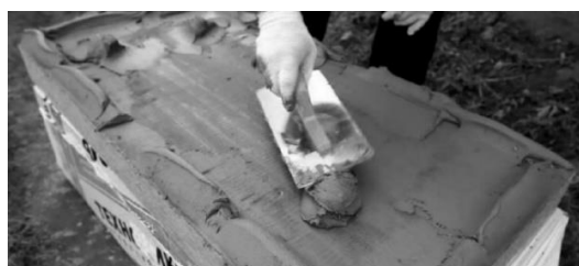
Рисунок 3.5 – Нанесение клея контурно-маячковым методом приклейки
