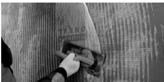
Рисунок 3.13 – Устройство базового штукатурного слоя, армированного стекло-сеткой
