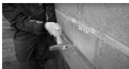
Рисунок 3.2 – Установка стартового профиля
