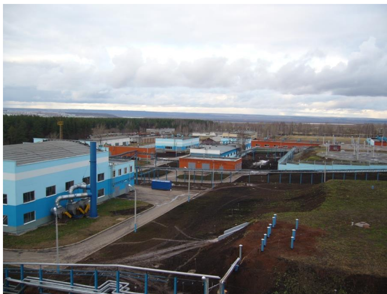
Рисунок 1 – АО «Станция очистки воды – Нижнекамскнефтехим»
