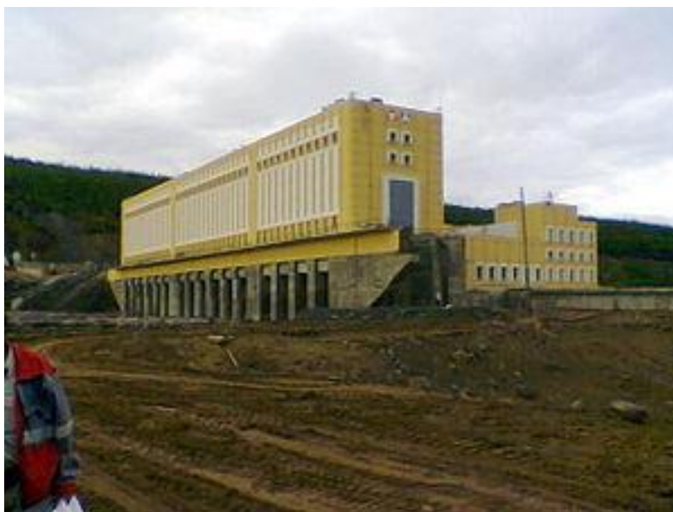
Рисунок 2 – Внешний вид Вилуйской ГЭС-3
