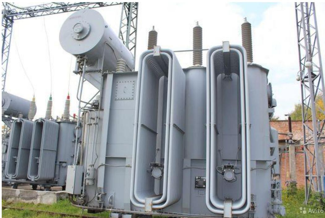
Рисунок 1 – Трансформатор ТРДН-25000/110
