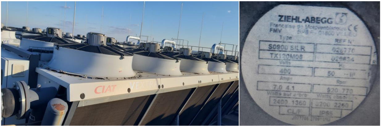
Рисунок 20 - Внешний вид сухой градирни и конденсатора
