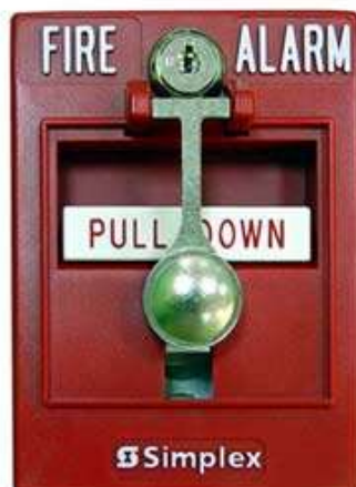
Рисунок 8 – Извещатель пожарный адресный ручной «4099-9001»
