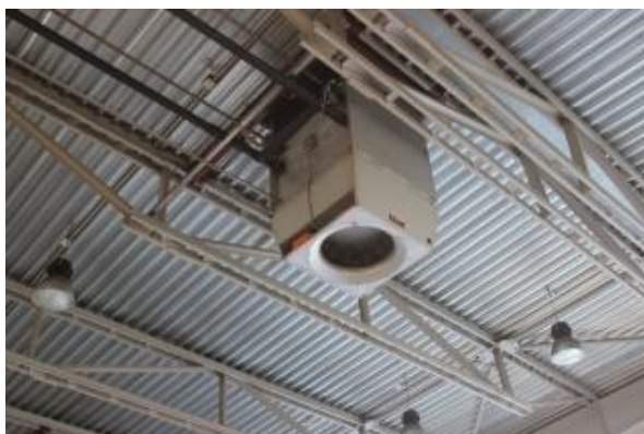
Рисунок 3 – Пример приточной установки децентрализованной системы вентиляции
