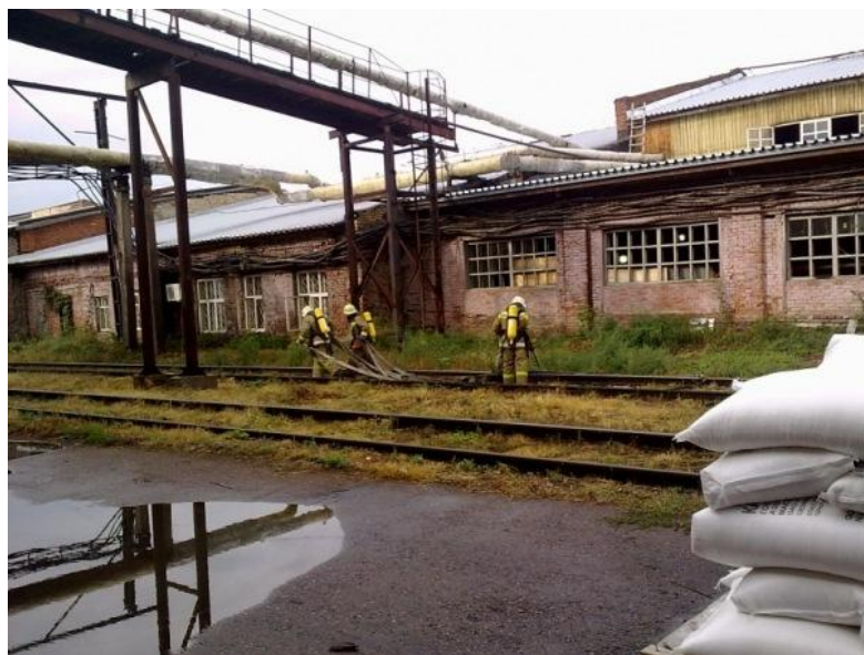
Рисунок 5 – Здание фанерного цеха ООО «УФПК»
