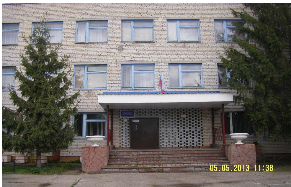
«Рисунок № 2» - Вид здания школы-интерната №5 со двора
