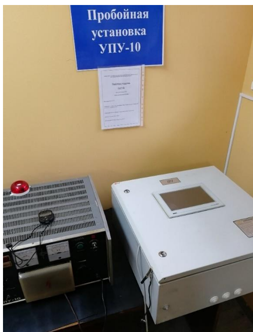
Рисунок 28 – Проверка электрической прочности изоляции
