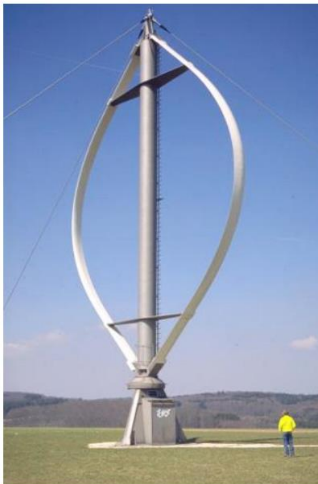
Рисунок 7 – Ветроустановка с вертикальной осью вращения с ротором Дарье
