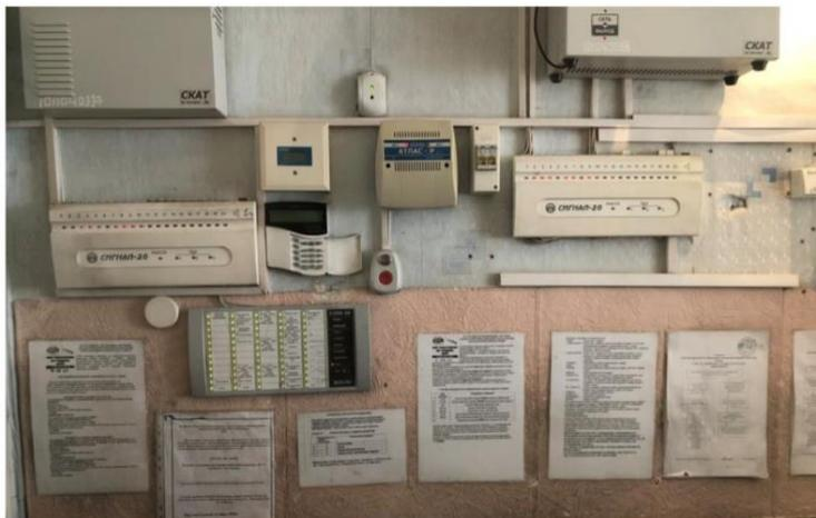
Рисунок 2 – Автоматическая пожарная сигнализация «Юнитроник 496»
