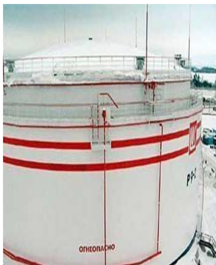
Рисунок Ж.3 - Охлаждение резервуаров
