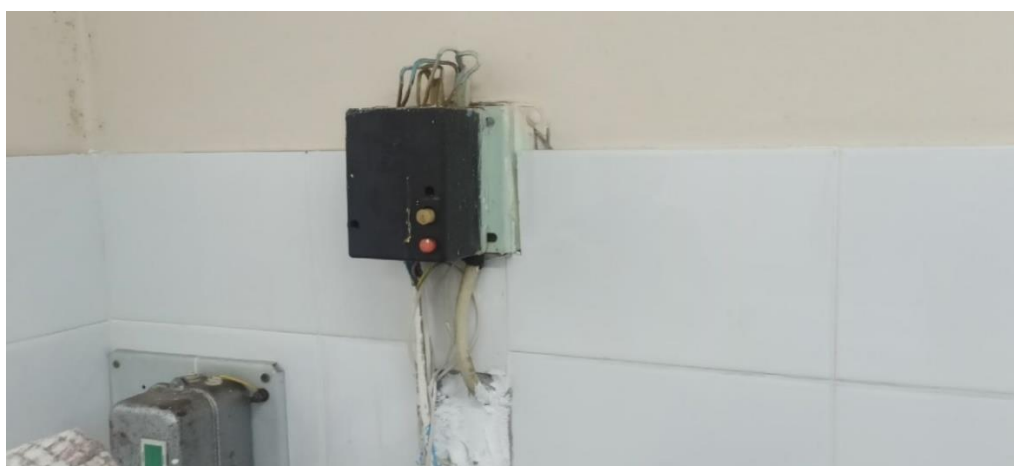
Рисунок 7 – Устаревшие коммутационные аппараты
