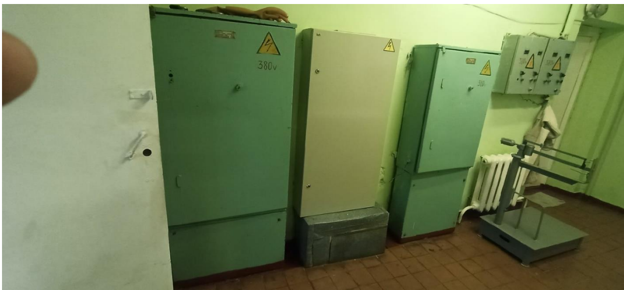
Рисунок 6 – РП установленные в пищеблоке
