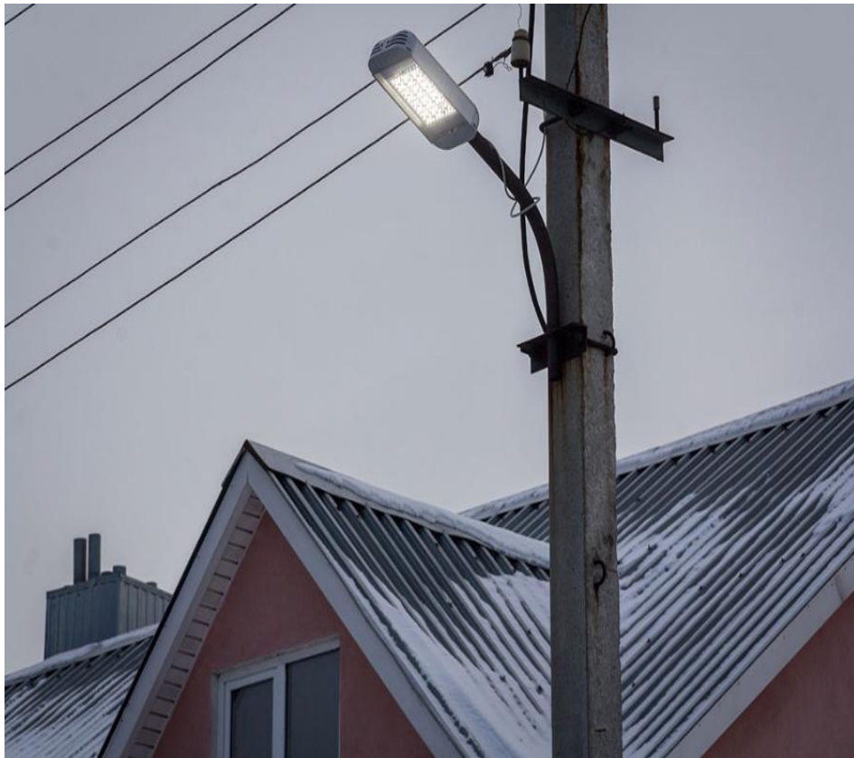
Рисунок 14 – Монтаж светодиодного светильника на опоре ВЛ 0,4 кВ
