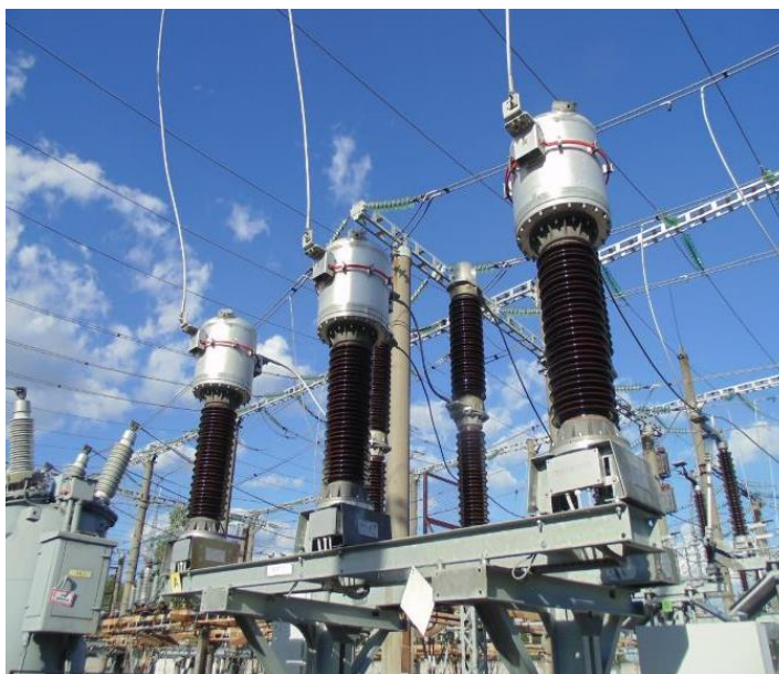
Рисунок 13 – Внешний вид трансформатора ТОГФ-110
