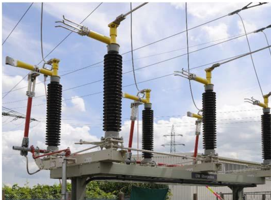
Рисунок 11 – Внешний вид разъединителя SGF
