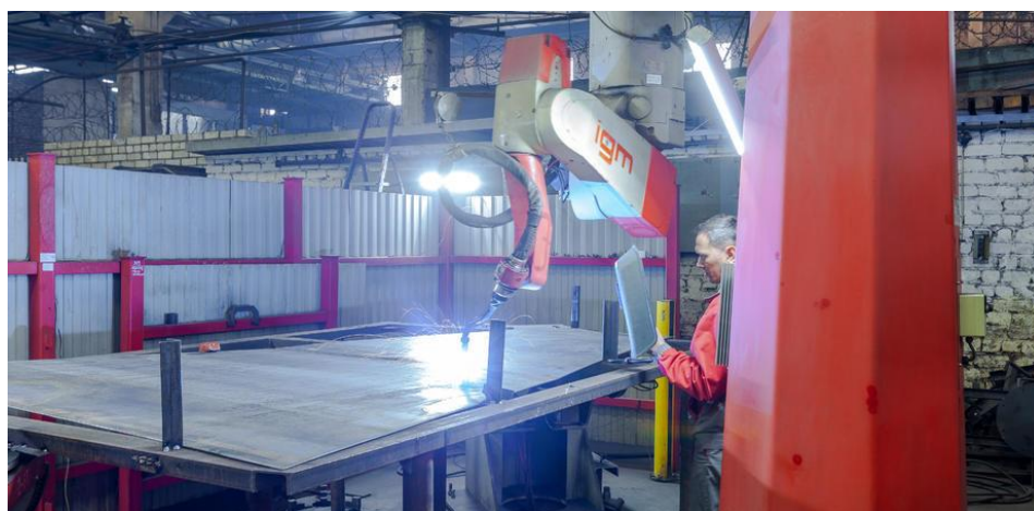
Рисунок 39. Сварка настила кровли
