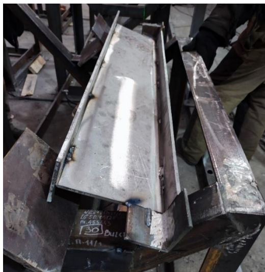
Рисунок 37. Сборка балки под сварку.
