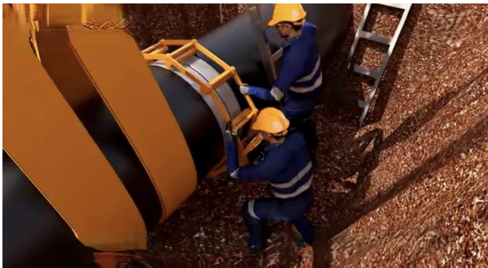
Рисунок 23 – Установка центраторов
