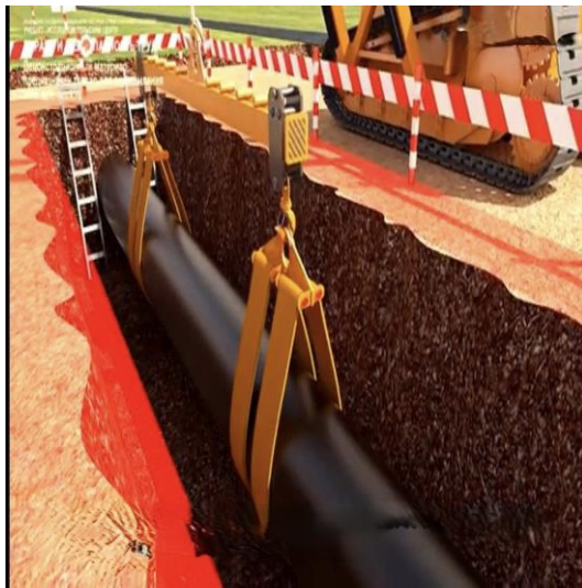
Рисунок 20 – Подготовка трубы к удалению дефектного участка
