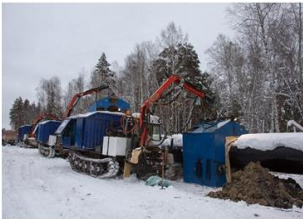
Рисунок 1- Внешний вид участка № 41 нефтепровода «Нижевартовск-Курган-Куйбышев» при проведении ремонтных работ
