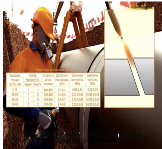
Рисунок 20 – Подготовка трубы к удалению дефектного участка
