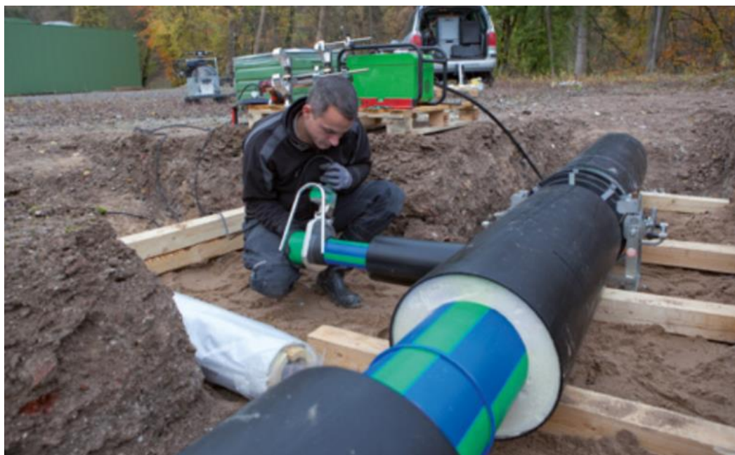
Рисунок 6 – Сборка и сварка трубопровода
