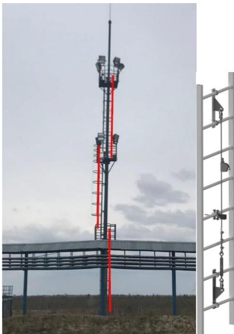
Рисунок 16 – Мачта освещения и схема установки СИЗ от падения с высоты
