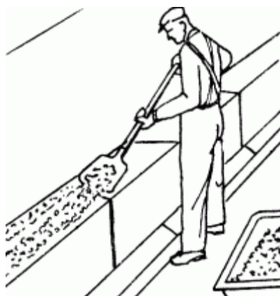
Рисунок 14 - Схема работы при расстилании раствора
