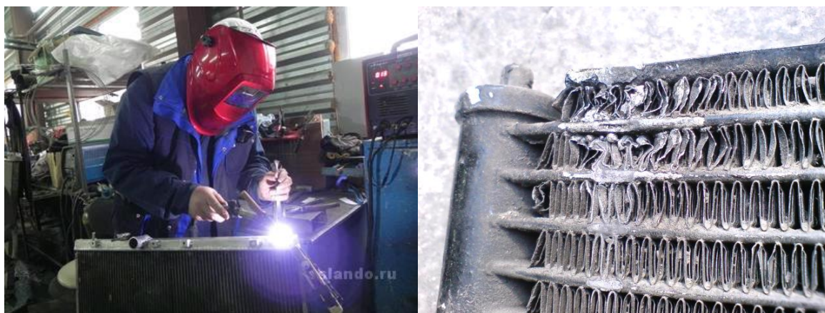
Рисунок 7 – Ремонт алюминиевых радиаторов сваркой
