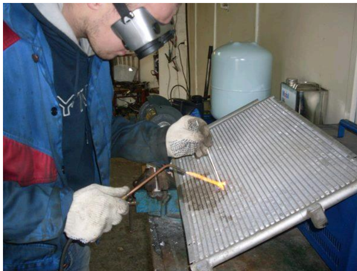
Рисунок 9 – Ремонт радиаторов пайкой
