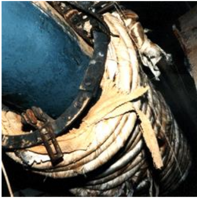
Рисунок 27 – Установка индукционного нагрева стыков труб
