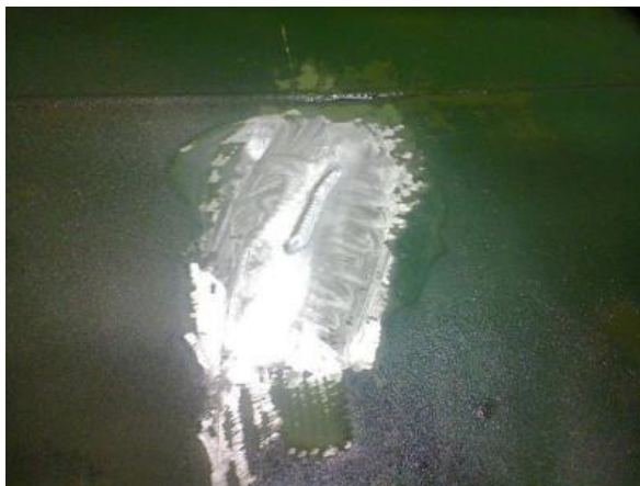
Рисунок 3 – Процесс ремонтной заварки трещины цистерны автогудронатора
