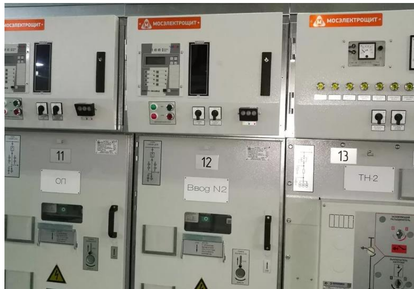
Рисунок 6 – Ячейки КРУ
