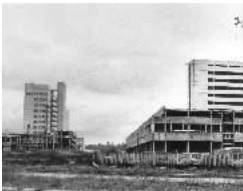
Рисунок 1 – Этап строительства городской клинической больницы №5
