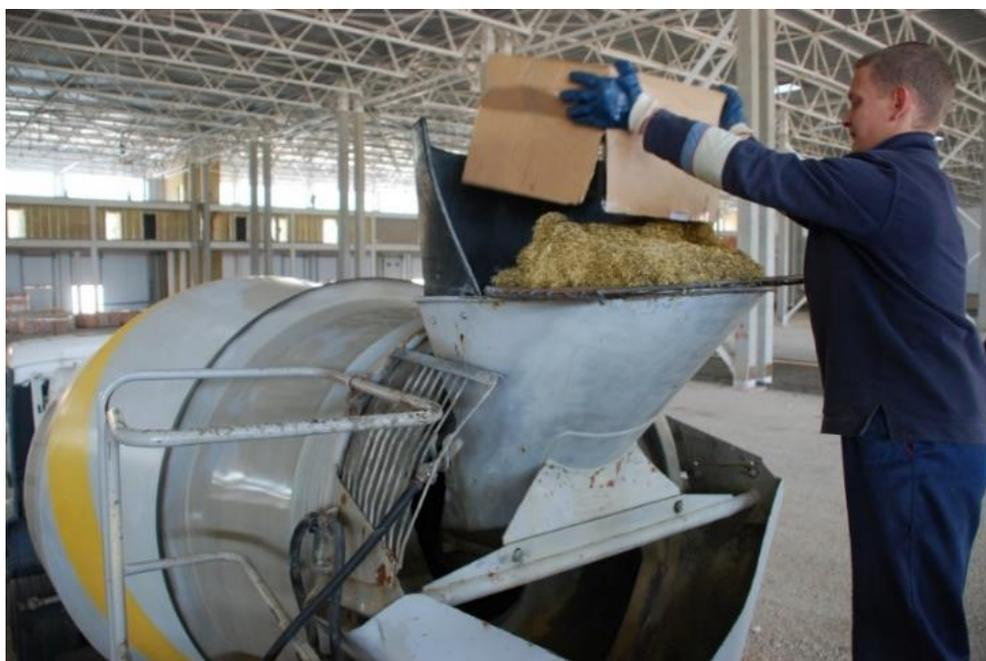
Рисунок 5 – Ручная подача фиброволокна в смеситель на базе автомобиля КАМАЗ-5310
