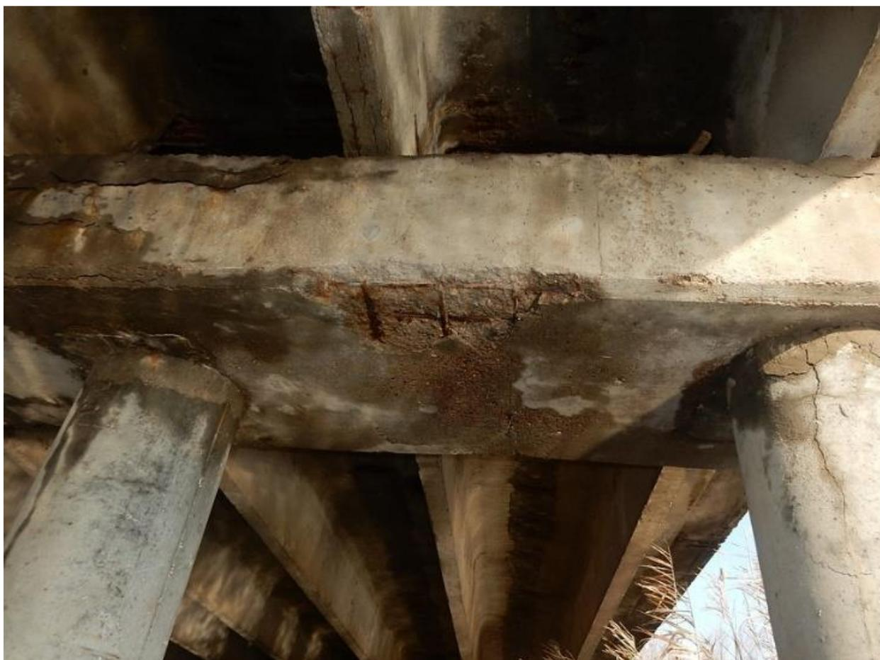
Рисунок 10 – Пример поражения оголенных участков арматуры элемента, расположенного в агрессивных условиях (повышенная влажность).
