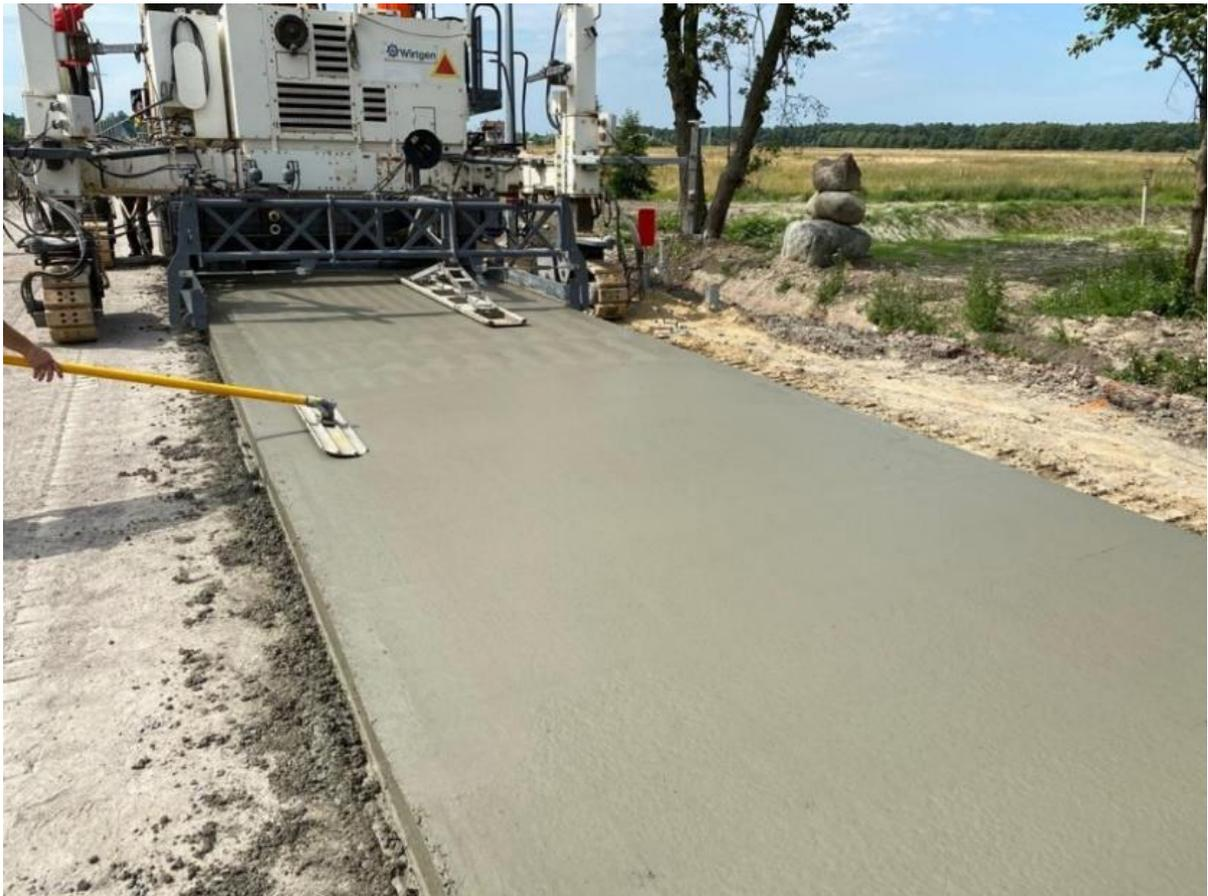
Рисунок 8 – Уплотнение фибробетона
