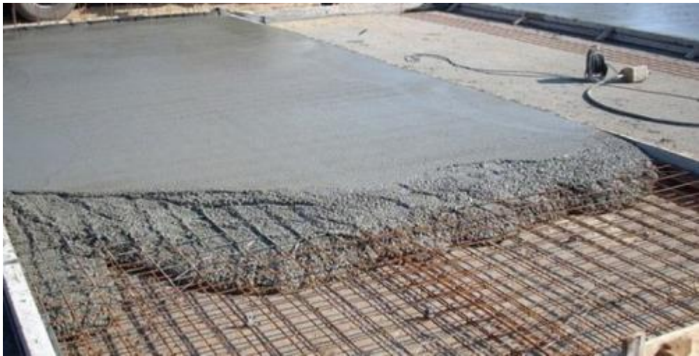
Рисунок 1 – Армирование железобетонных конструкций
