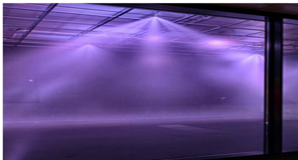
Рис. 4. Система HI-FOG в работе [4]
