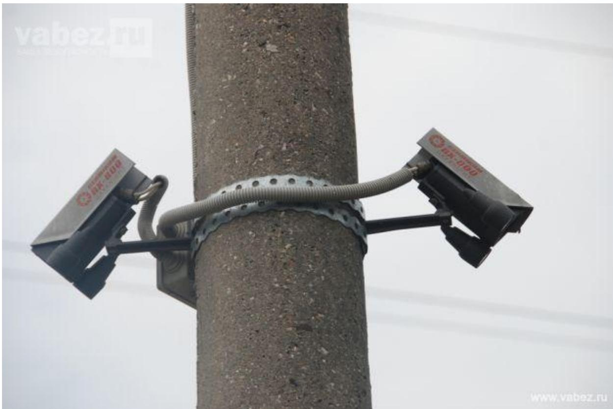
Рисунок 1.15 - способ установки видеокамер.
