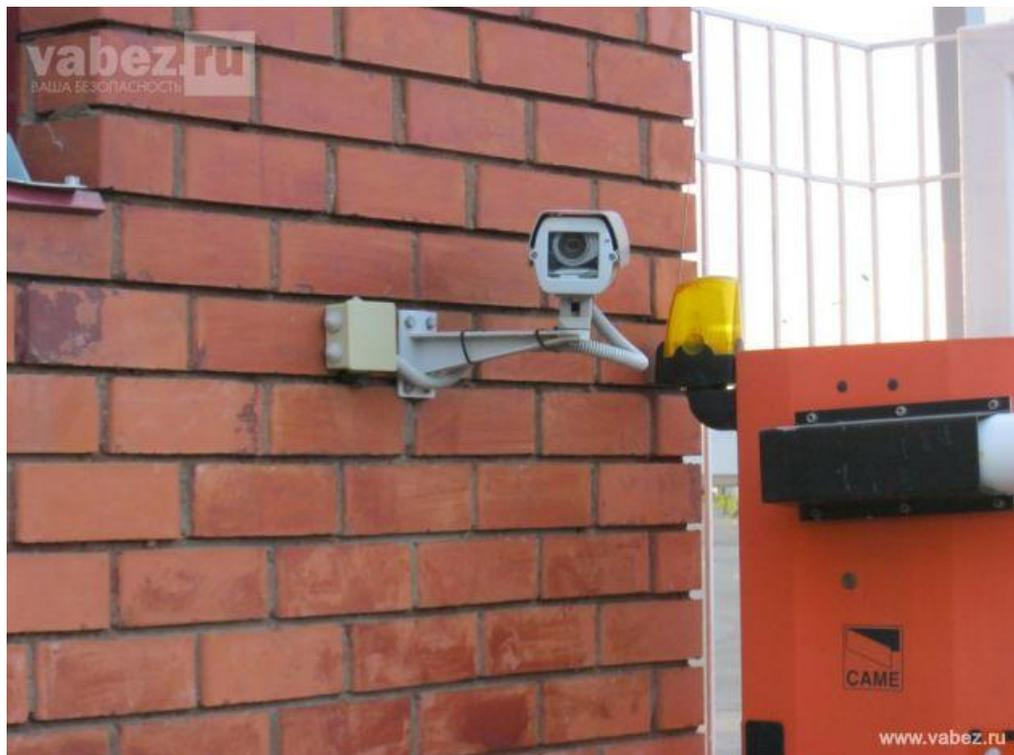
Рисунок 1.12 - способ установки видеокамер.
