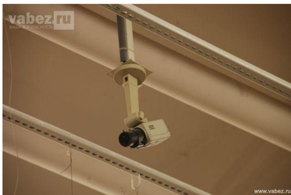
Рисунок 1.8 - способ установки видеокамер.
