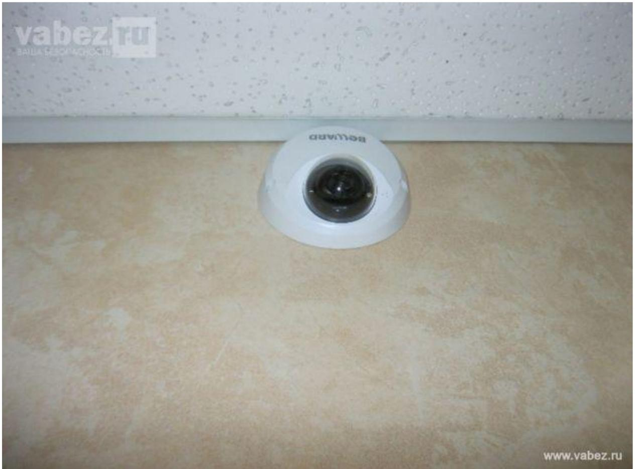
Рисунок 1.10 - способ установки видеокамер.
