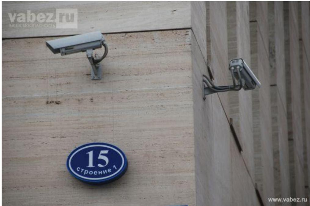
Рисунок 1.11 - способ установки видеокамер.
