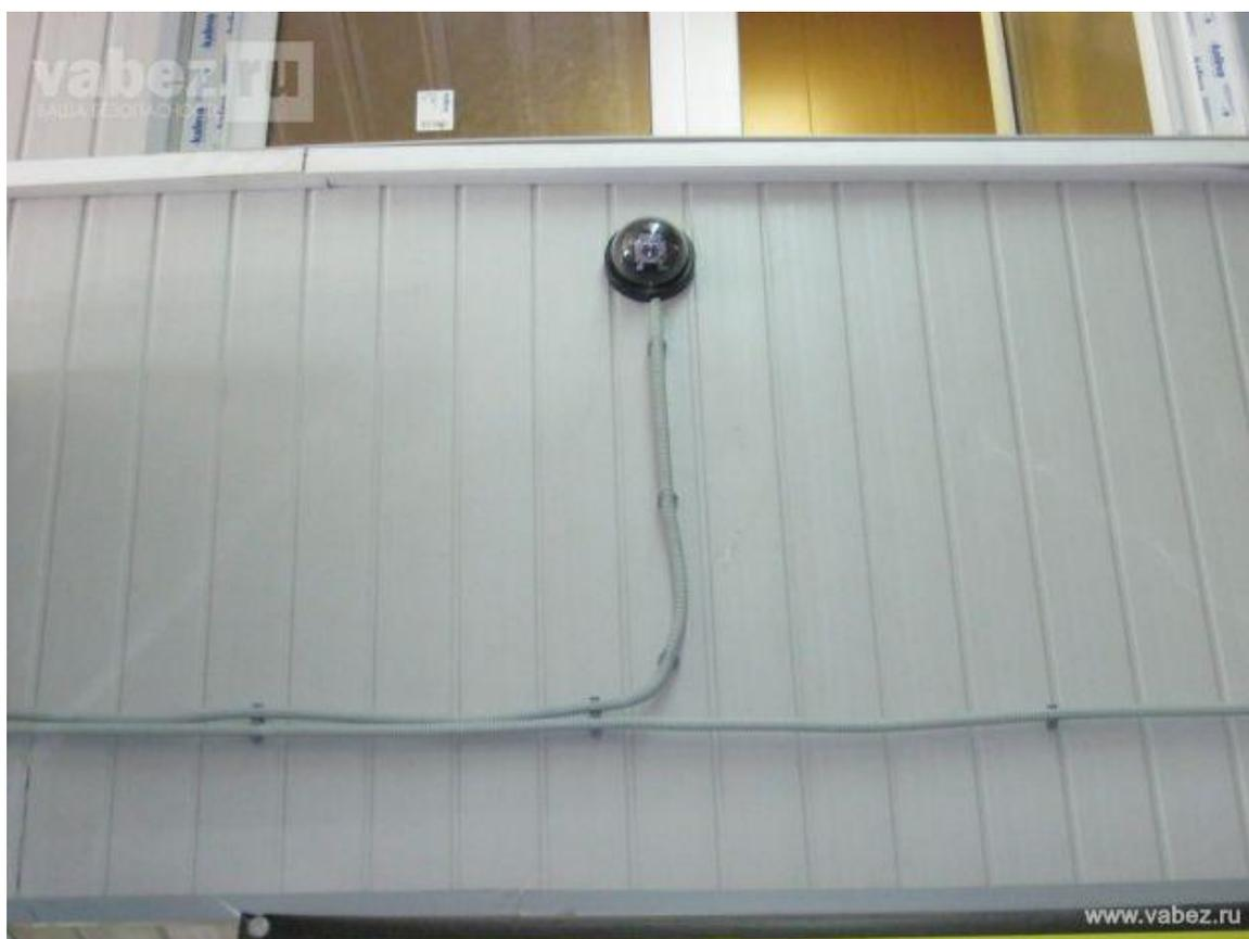
Рисунок 1.9 - способ установки видеокамер.
