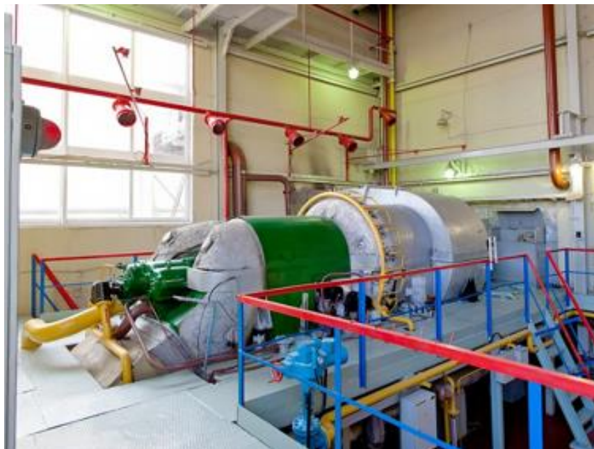
Рисунок 6 – Размещение ГПС-600 на ГПА
