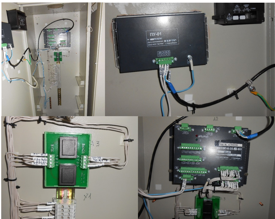
Рисунок 10 – Итоговый монтаж шкафа МК33П
