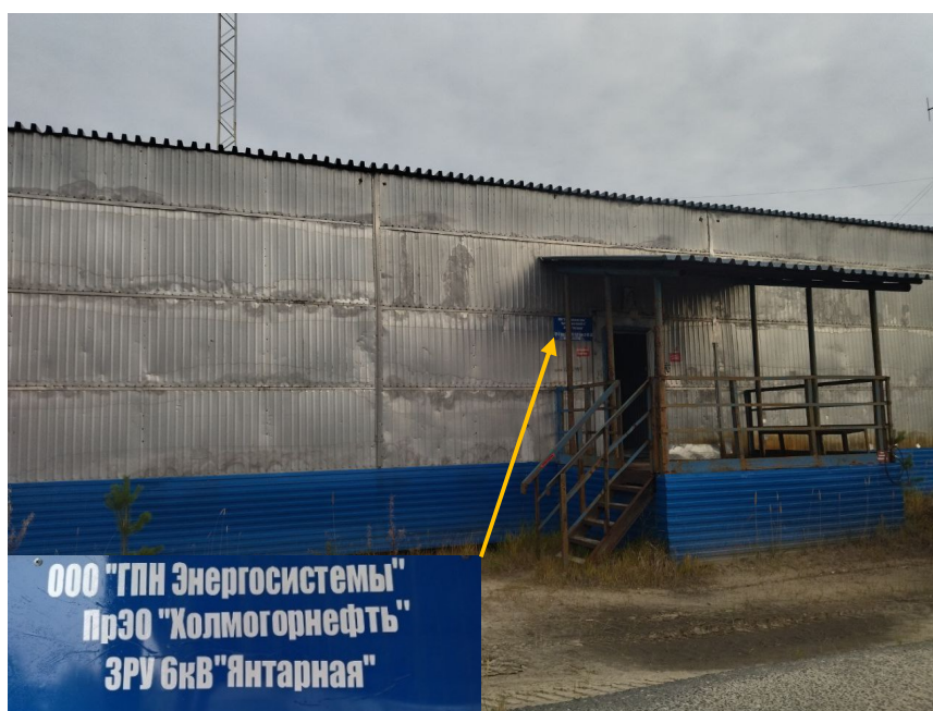
Рисунок 1 – Внешний вид ЗРУ-6кВ «Янтарная»
