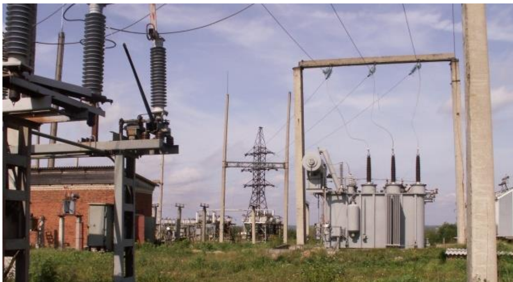
Рисунок 1– ОРУ 110 кВ ПС 110/10 кВ Ялutorовск
