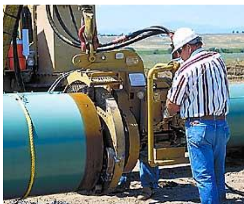
Рисунок 6 – Подготовка кромок труб с использованием станка PFM 3456
